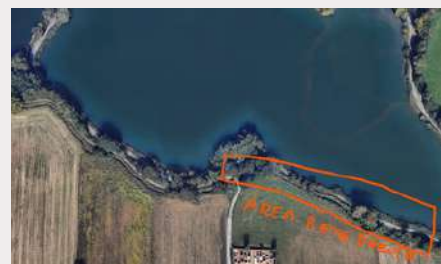
area dove è stata danneggiata la rete
