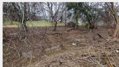
danni della rete particolare
