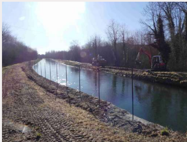
Lavori di recinzione "Giarola"
